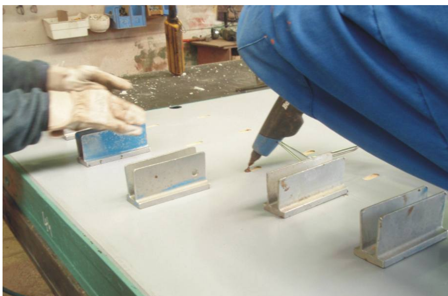
Obr. 19: Vyfrézované miesto sa vyplní výplňovou hmotou - roztaveným granulátom NOEboard a ochladí chladiacim blokom
