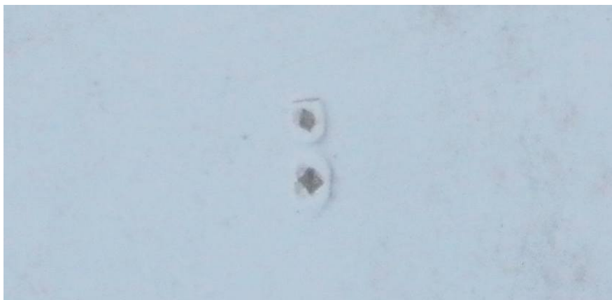
Obr. 12: Diery po kľincoch alebo skrútkách sa pri nasledujúcej betonáži zatvoria sami
