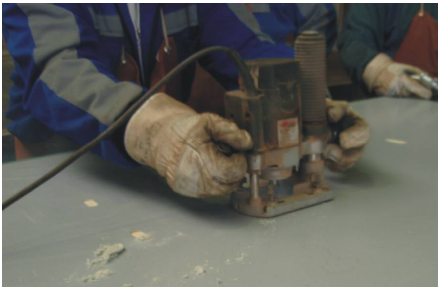
Obr. 18: Frézovanie poškodeného miesta
