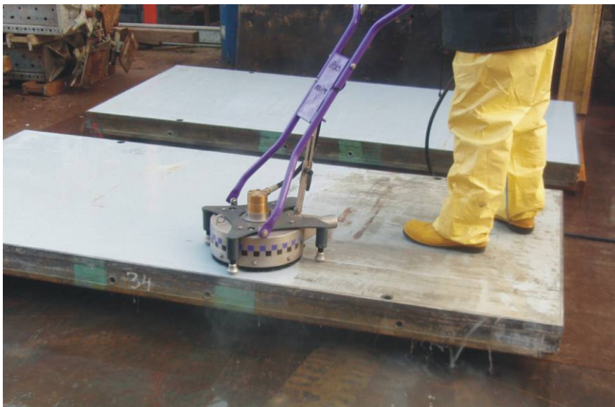
Obr. 10: Čistenie vysokotlakovým plošným čističom s plochými vodnými lúčmi
